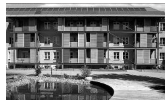
Heizkraftwerk auf dem Dach. 856 Quadratmeter Sonnenkollektoren liefern saubere Wärmeenergie. FOTO: TATIANA HEKNER
