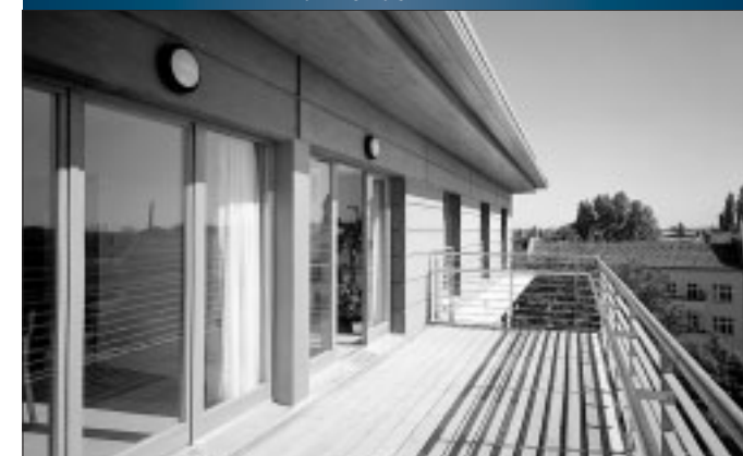
Made by INGBAU. Seniorenheim Gürtelstraße 32 im Berliner Stadtteil Prenzlauer Berg FOTO: INGBAU
