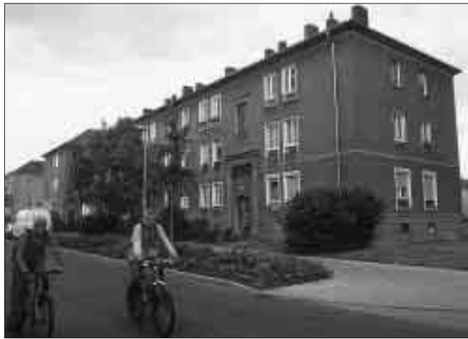
Nauener Straße 14/16/18: Zur Zeit sind nur noch 30 Prozent der Wohnungen vermietet.
