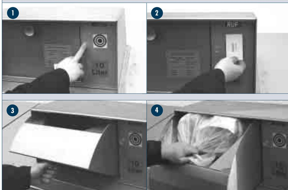
1. Die Stromversorgung der Müllschleuse per Tastendruck aktivieren. Ist der Container voll, meldet das Display „FULL“. Sie müssen die andere Müllschleuse benutzen. Zuerst ist hier auch die Stromversorgung zu aktivieren.
