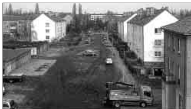
Das Ende der Buckelpiste – ab April wird die Bergstraße zur Baustelle.
