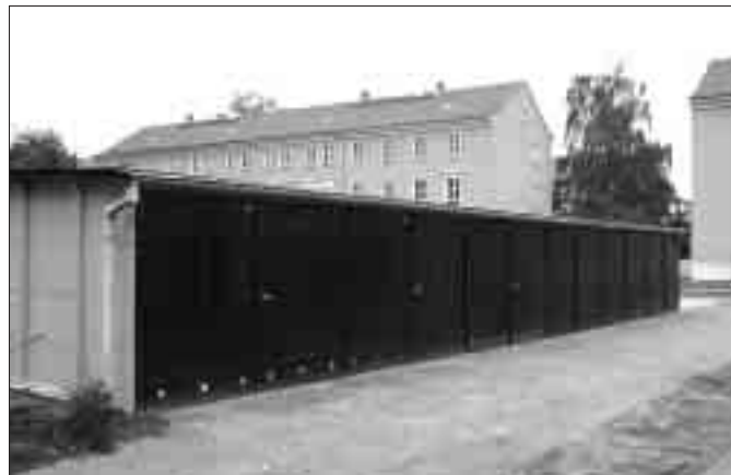
Die frisch gestrichenen Garagen an der Fasanenstraße fallen nicht mehr aus dem Bild. FOTO: HERKNER
