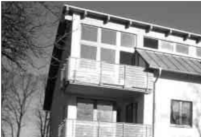
Neubauvorhaben 1998/99: die Havelvillen in der Dorfstraße
