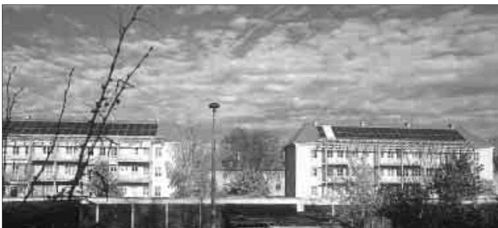
Das Cohnsche Viertel. Der erste Bauabschnitt in der Nauener Straße ist pünktlich zum Jubiläum fertig.
