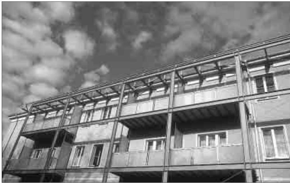
Neue Balkons und leuchtende Fassaden: Die sanierten Häuser in der Nauener Straße können sich sehen lassen.
