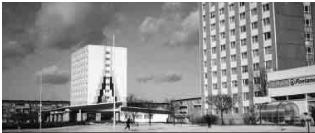
Farbe für die Stadt. Elfgeschosser vor und nach der Sanierung
