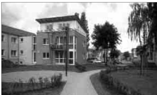
Sanierte Bestandsgebäude und moderne „Anbauten“ in der Aktivistensiedlung FOTO: TATJANA HERKNER
