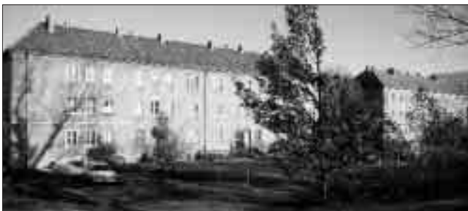
Solaranlagen auf den Süddächern werden das Viertel mit warmem Wasser versorgen.
