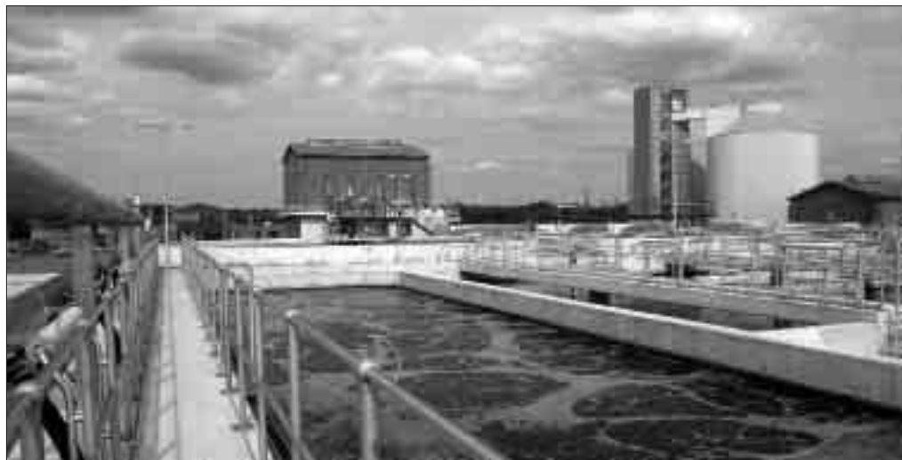
Das neue Klärwerk Wansdorf verarbeitet Abwässer von Hennigsdorf, Falkensee, Berlin und anderen Kommunen.
