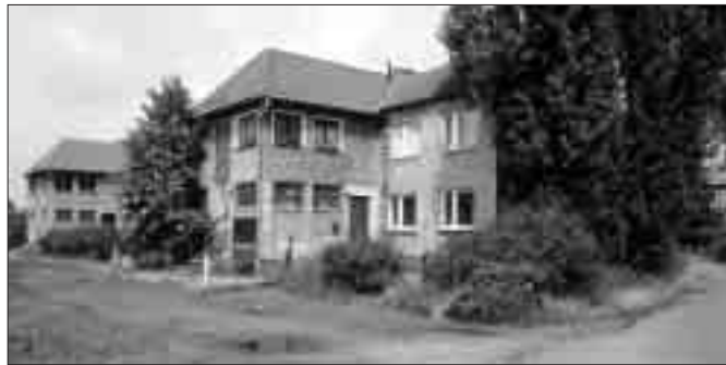
Die Not-Treppenhäuser vor den Baumaßnahmen.
