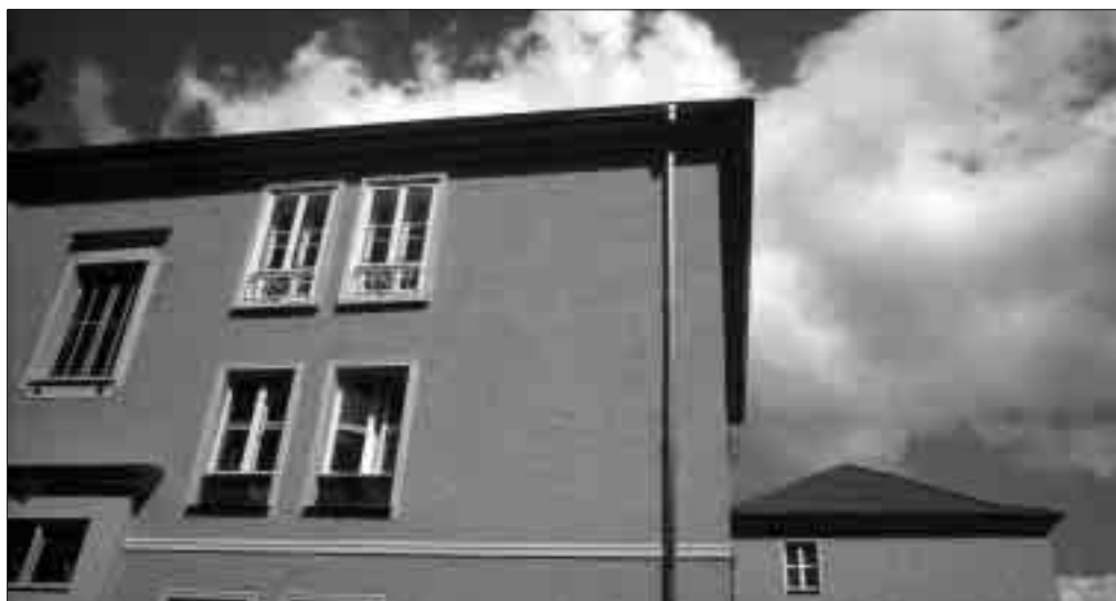
Die alten Kastenfenster in der Klingenbergstraße mußten saniert und die Wände von innen gedämmt werden.
