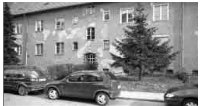
Eigentumsverhältnisse nicht geklärt – das marode GEWOBAG-Viertel kann nicht saniert werden.
