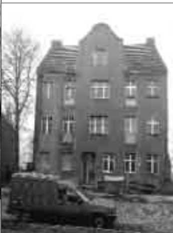
die Stadtvilla Seilerstraße 2a werden saniert.
