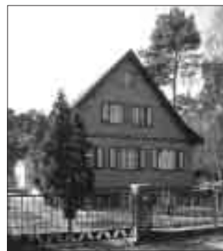
Das ehemalige Gemeindehaus in Stolpe-Süd
