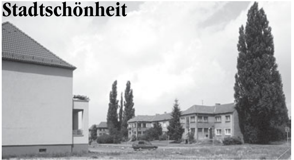
Die Aktivistensiedlung wird gründlich saniert, moderne Anbauten werden die alten Treppenhäuser ersetzen
