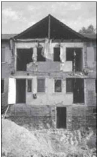
Der Abriss der Treppenhäuser hat begonnen
