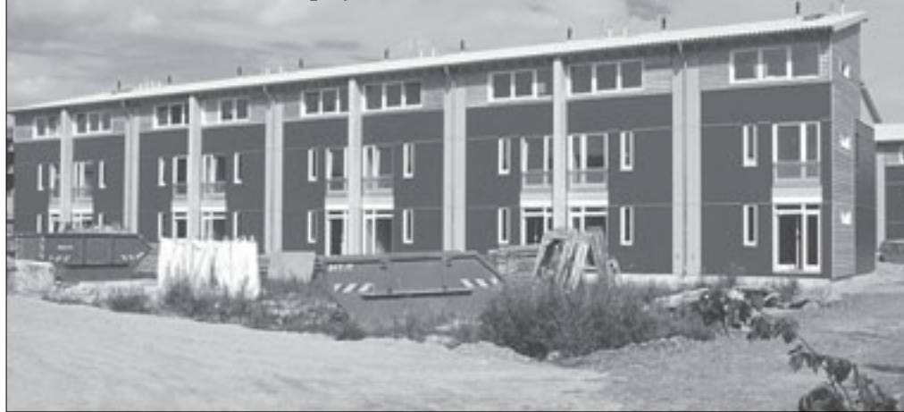
Naturnah gelegen mit allen Vorteilen der Stadtnähe: die Siedlung „Am Waldrand“
