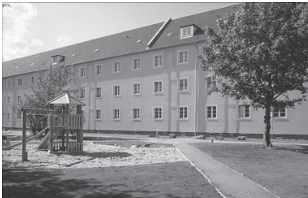
Mit der Gestaltung hochwertiger Außenanlagen wurde die Sanierung der Siedlung Seilerstraße im September abgeschlossen
