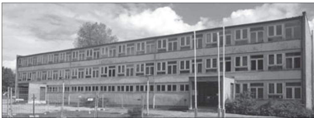
Das marode Oberstufenzentrum wird demnächst saniert
